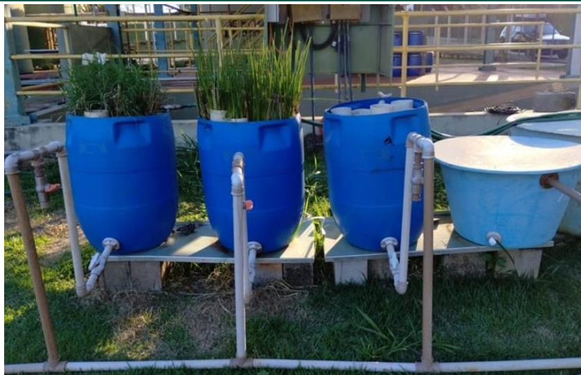
Figura 1. Unidade experimental montada na ETE-UFLA
